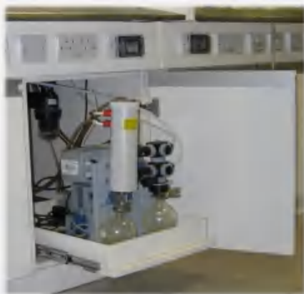
噪音设备安装柜
