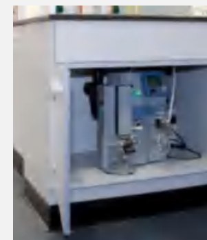
噪音设备安装柜
